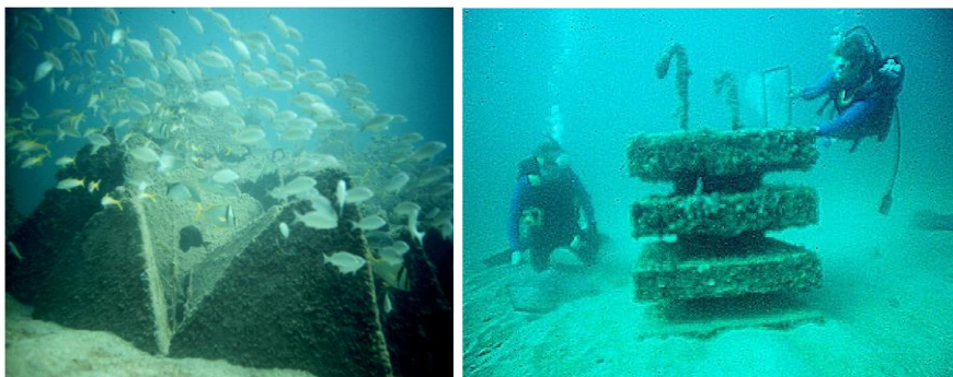
Рисунок 1.23 – Штучні рифи у вигляді модулів «тетрахендронс» («tetrahendrons») у вигляді модулів «fish-condo». Світлина Richard E. (Spieler Ertificial reef research)
