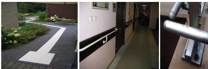
Рисунок 9.7 – Особливості улаштування шляхів з застосуванням брайлівських доріжок: а – облаштування шляху тактильними напрямними; б – облаштування поручнями; в – облаштування з використанням перил з текстом шрифтом Брайля
