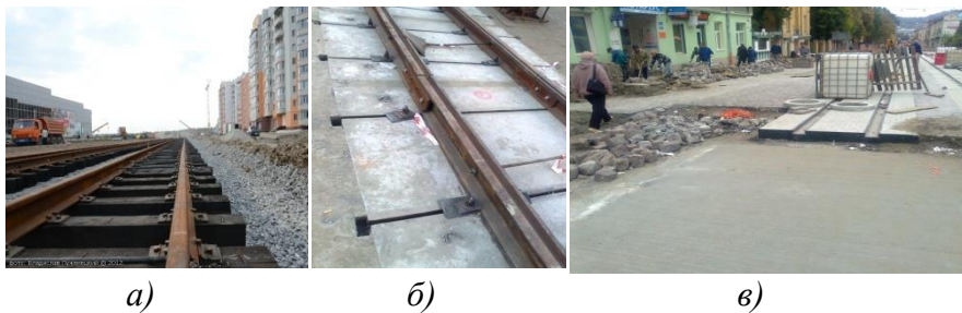
Рисунок 6.11 – Способи укладання рейок трамвайних шляхів: а – технологія 1950 року; б – технологія 1980 року; в – технологія 2000 року
