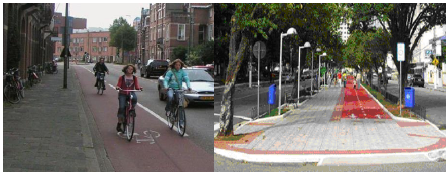
Рисунок 7.7 – Влаштування велодоріжок на проїзній частині (а) та на пішохідних тротуарах (б)
