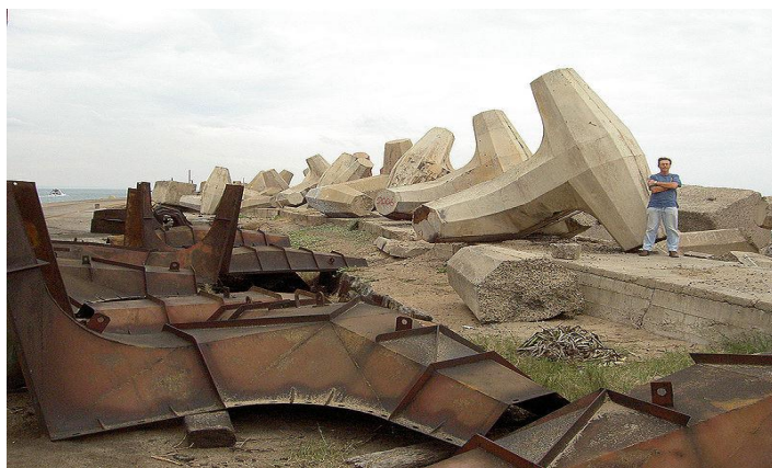
Рисунок 1.21 – Застосування долосів Dolos (dolosse, переклад – "кулак кістки")
