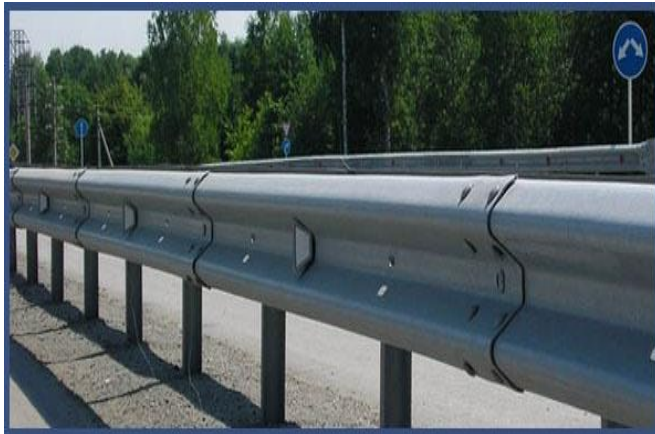
Рисунок 3.3 – Металеві профільні огороження
