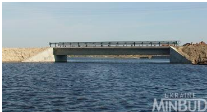
Рисунок 4.13 – Балочна система моста
