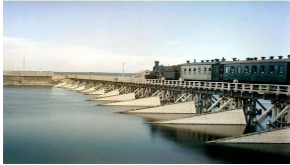
Рисунок 4.28 – Міст із кригозахисними пристроями (початок XX ст.)
