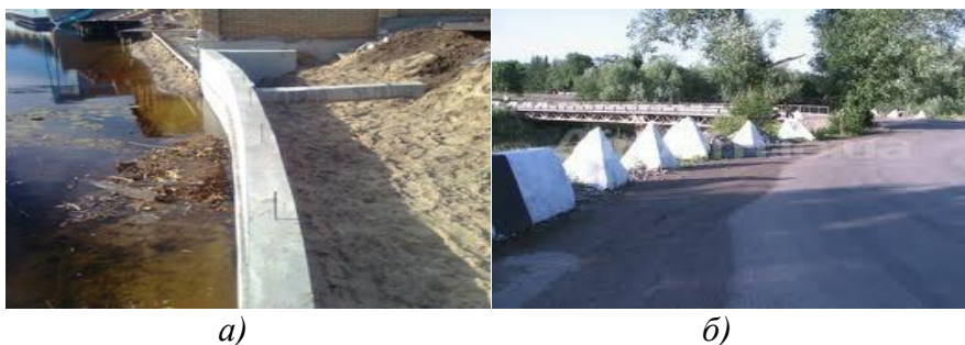
Рисунок 1.16 – Укріплення берегів: а – монолітним залізобетоном; б – залізобетонними тетраедрами, приготвленими для скидання на відкоси ріки
