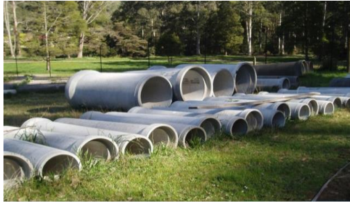
Рисунок 4.31 – Водопропускні труби перед укладанням в полотно дороги
