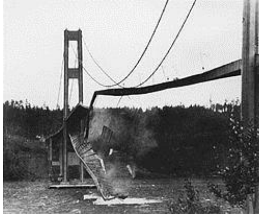
Рисунок 4.9 – Такомський міст зруйнований через виникнення резонансу
