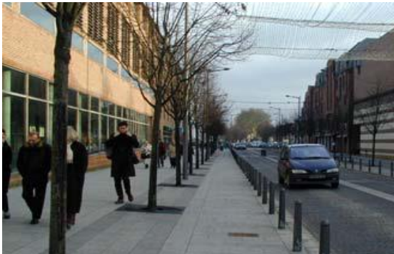
Рисунок 7.5 – Варіант улаштування велосипедної доріжки, відокремленої від тротуару та проїзної частини вулиці
