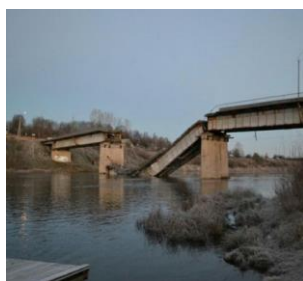
Рисунок 4.3 – Результат дії землетрусу: а – на земну кору; б – на споруди дорожньої інфраструктури
