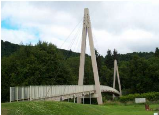
Рис. 8.5. Пішохідний міст в Аберфелді
