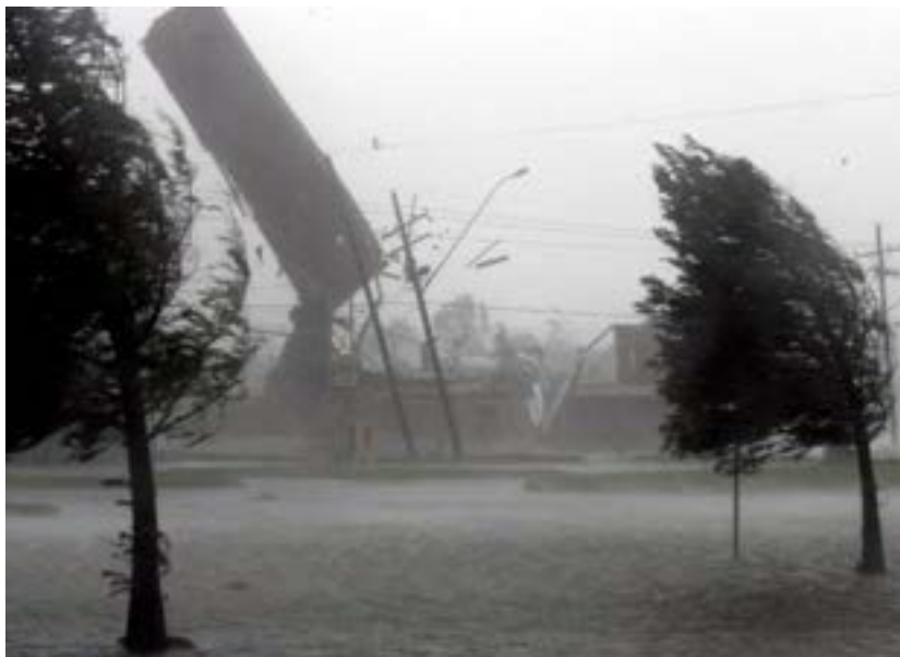
Рис. 1.58. Пориви шквального вітру зривають з основи дерев'яну вежу, гнуть стовпи ліній електропередач та пригинають дерева
