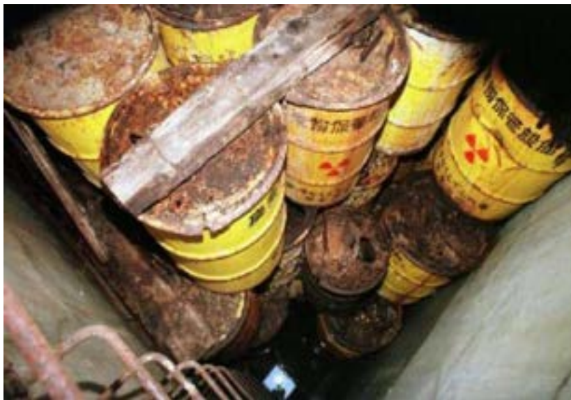
Рис. 1.25. Незадовільний стан зберігання РАВ внаслідок втрати герметичності сховища
