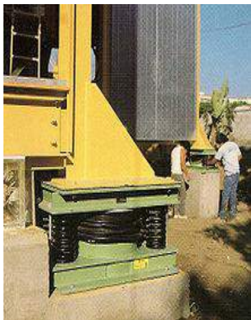
Рис. 4.23. Приклад системи сейсмоізолюючого фундаменту з пружними елементами
