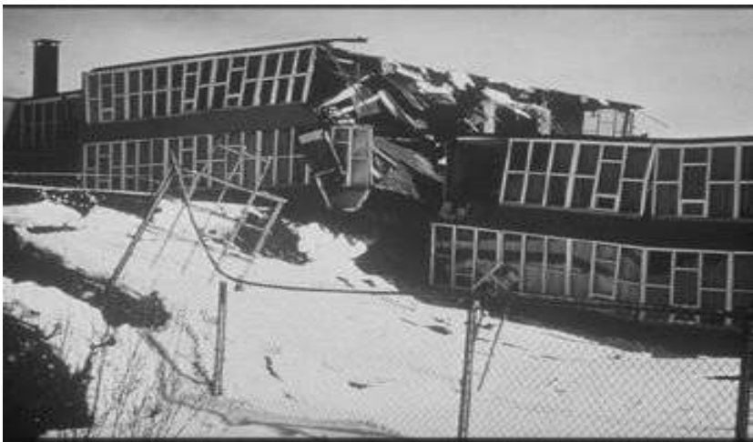
Рис. 4.32. Руйнування будинку внаслідок просідання ґрунту (а)
