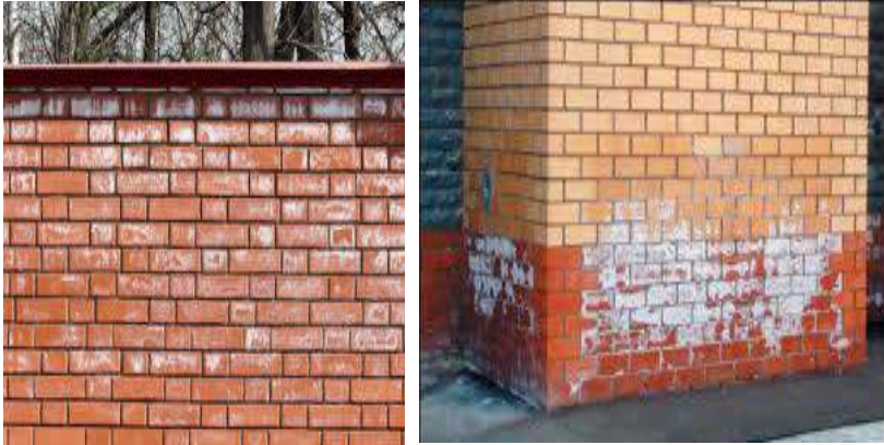
Рис. 4.37. Висоли і мокрі плями на цегляній кладці
