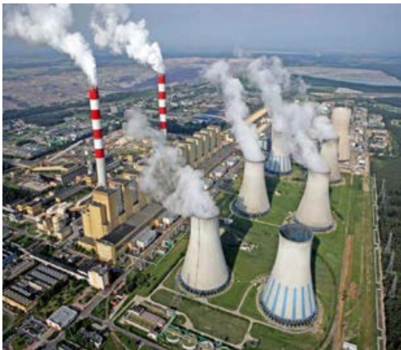
Рис. 1.22. Загальний вигляд атомної електростанції (АЕС)
