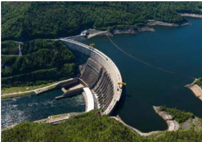
Рис. 1.31. Вид з висоти на гідроспоруду водосховища ГЕС
