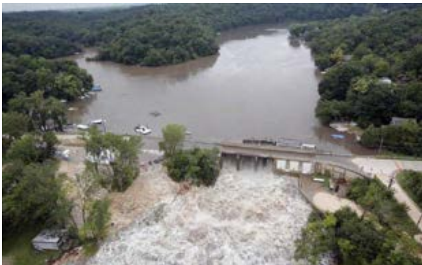
Рис. 1.32. Прорив води через несправність шлюзу дамби
