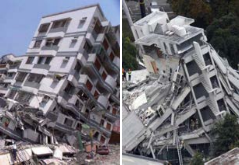
Рис. 4.17. Руйнування каркасного будинку під час землетрусу
