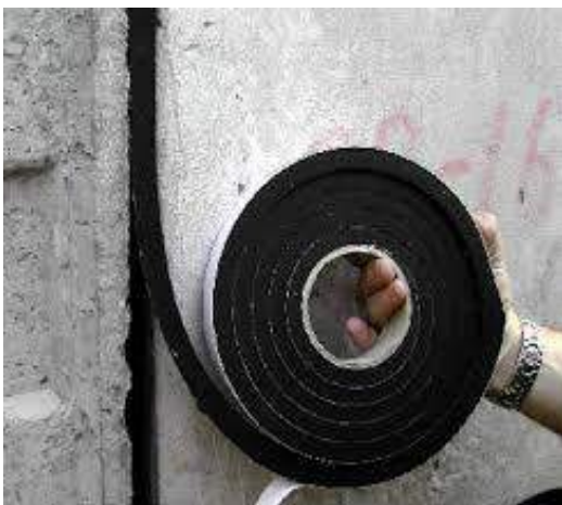
Рис. 4.10 Антисейсмічний шов та його ущільнення гумовою стрічкою
