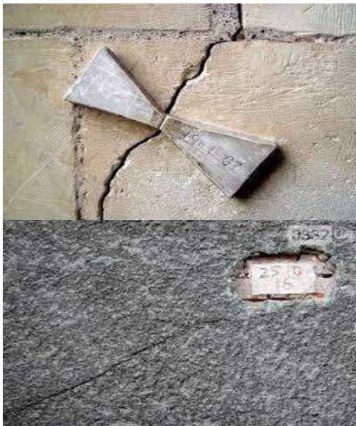
Рис. 4.36. Встановлений маяк на стіні будівлі
