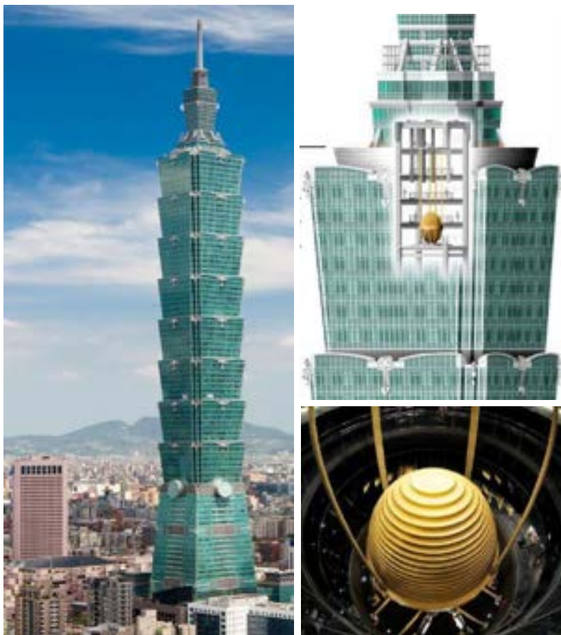
Рис. 4.29. Динамічний гаситель коливань інерційного типу у 508-метровому хмарочосі Тайбей в Тайвані
