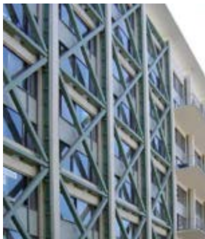
Рис. 4.27. Пластичні енергопоглиначі в системах зв'язків сталевих каркасів
