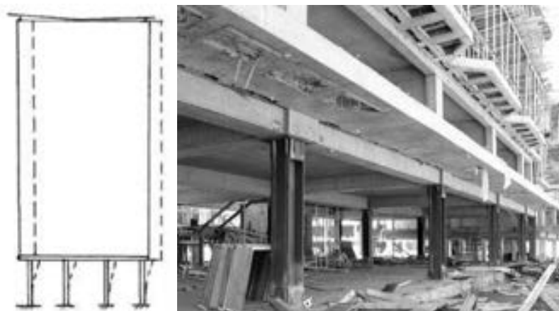
Рис. 4.21. Система будівлі з першим гнучким поверхом
