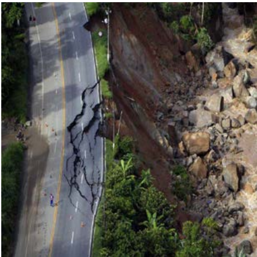
Рис. 1.44. Утворення зсуву у гірському районі внаслідок перезволоження ґрунту через інженерні прорахунки під час прокладання автомобільної дороги
