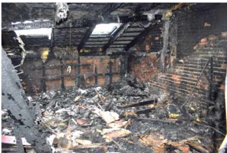
Зображення 20. Вигляд частини приміщення четвертого поверху
