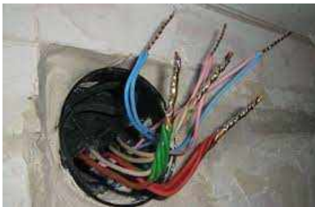
Рис.49. Правильне з'єднання дротів один з одним
