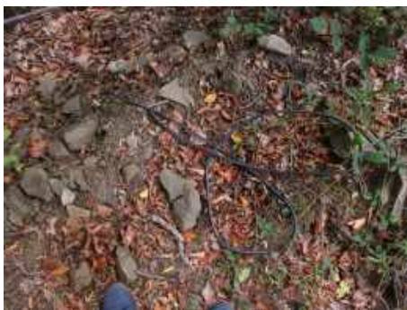
Зображення 16. Вигляд електричних проводів зовні приміщення
