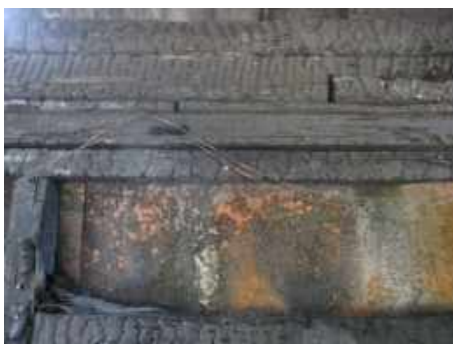
Зображення 14. Вигляд електричних проводів з ознаками короткого замикання
