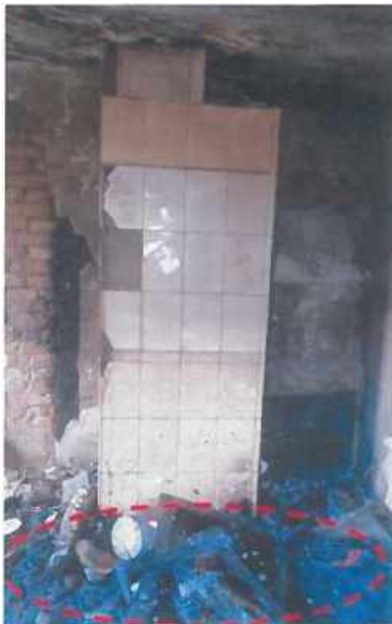
Рис.66. Зображення аномальної зон термічного впливу на нижніх частинах предметів речової обстановки в приміщенні
