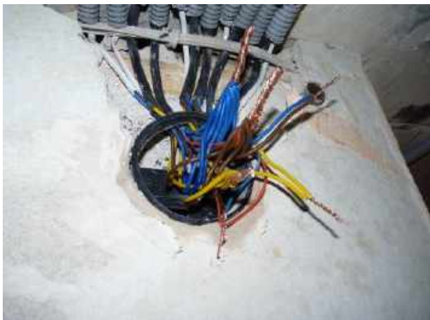
Рис.48. Неправильне з'єднання дротів один з одним
