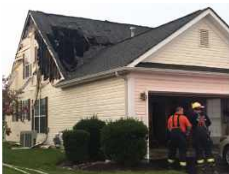
Рис.30. Результат влучання блискавки в неметалеву покрівлю будинку без блискавкозахисту
