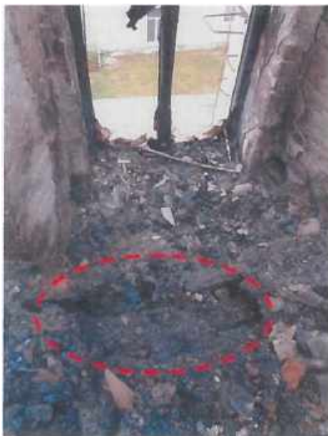
Рис.66. Зображення локального прогару підлоги, який утворився під тумбою письмового стола внаслідок проливання ЛЗР чи ГР
