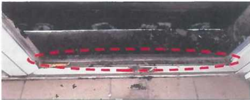
Рис.63. Сліди горіння, характерні для затікання ЛЗР або ГР у щільну під полотном дверей
