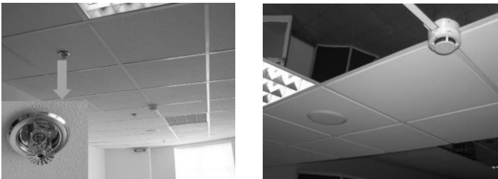
Рисунок 3.2 – Способи монтування АСПГ
