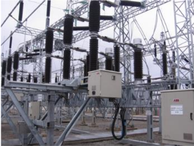
Рис. 1.11. Загальний вид трансформаторної електростанції
