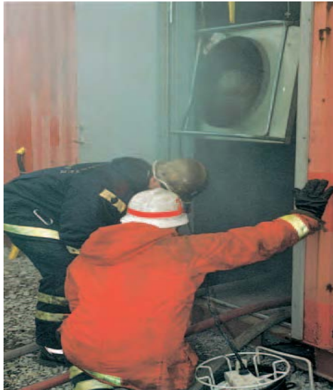
Рис.4.1. Приклад встановлення пожежного димовсмоктувача, що працює на відсмоктування продуктів згорання
