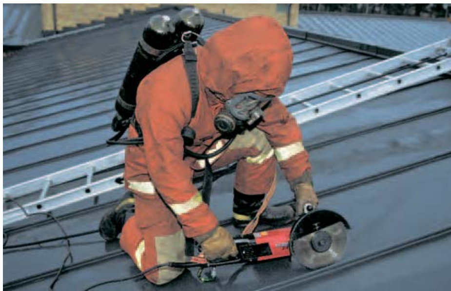
Рис.4.15. Приклад розкриття металевого дахового покриття з використанням дискової пили
