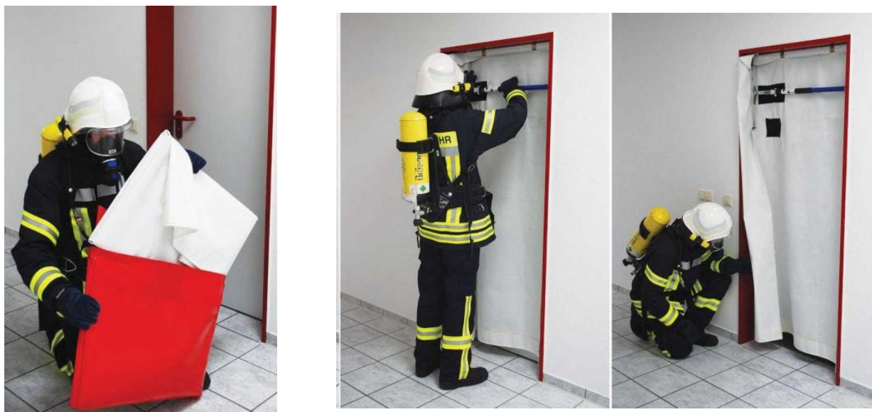
Рис. 4.12. Протипожежна димова перемичка: а) двері перед установкою перемички; б) монтування протипожежної димової перемички.
