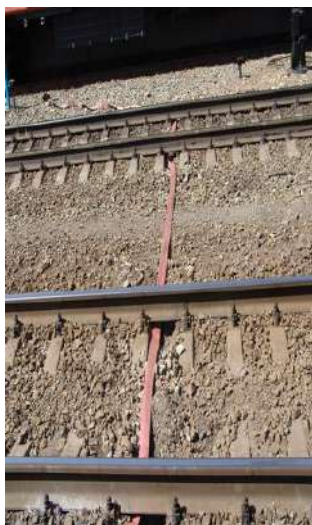
Рисунок 2.70. Прокладання рукавних ліній через залізничні і трамвайні колії
