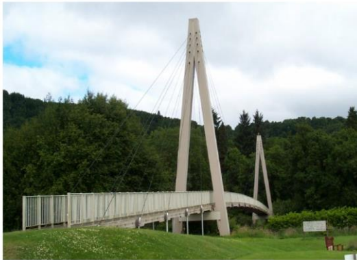
Рис. 8.5. Пішохідний міст в Аберфелді
