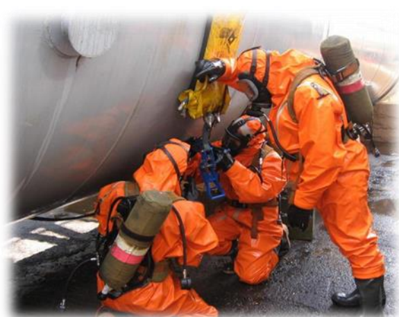
Рис. 1.3. Ліквідація виліву (викиду) НХР за допомогою бандажів
