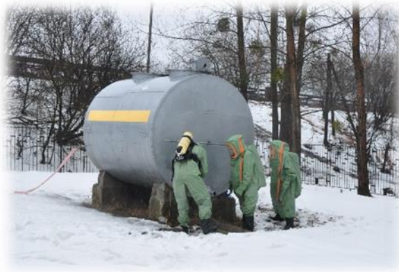
Рис. 1.2. Перекриття кранів і засувок з НХР
