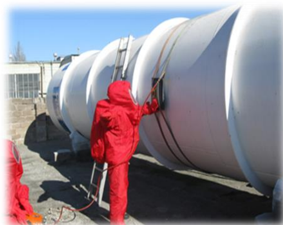
Рис. 1.3. Ліквідація виліву (викиду) НХР за допомогою бандажів
