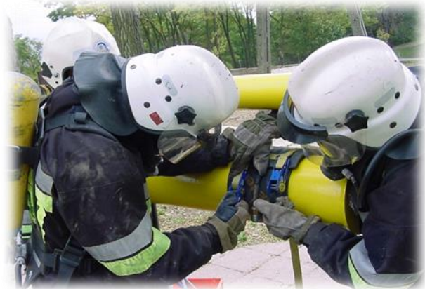
Рис. 1.4. Ліквідація вилу (внкнду) НХР за допоногоу хомутів
