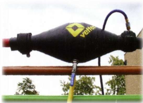
Рис. 1.6. Локалізація витоків НХР за допоногоу спеціальних ущільнювачів
