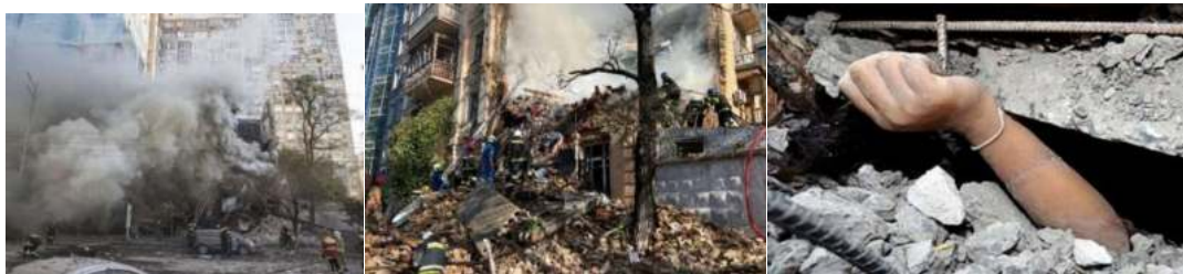
Рисунок 1 – Приклади руйнувань будівель і споруд внаслідок ракетного удару під якими опинилися люди
