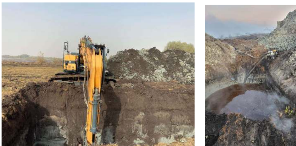
Рисунок 3 – Побудування водоймища-копані та подаванням води мотопомпою
